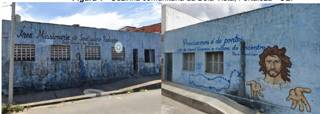
Figura 1 - Cozinha comunitária da Bela Vista, Fortaleza - CE.
